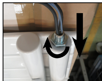
Mettre la résistance en place et la serrer à 3,5 daN.m.
