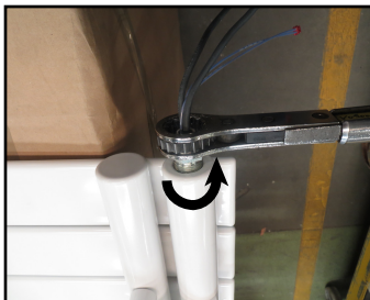
Dévisser la résistance à l'aide d'une clé à cliquet de 24.
