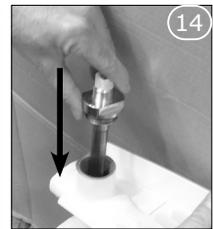
Introduire la résistance dans son compartiment. Serrer la résistance à 5 daN.m avec la clé dynamométrique.
