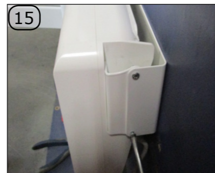
Dévisser complètement les 4 vis « apparentes » (deux vis du haut sur la platine et vis la plus à l'intérieur de l'appareil pour les consoles rotatives haut et bas).
