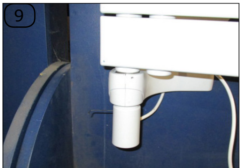
Déposer le soufflant.
