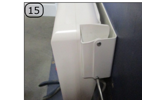
Befestigen Sie den Heizlüfter mit den vier Schrauben des alten Heizlüfters an der Halterung.
