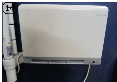
Replacer le soufflant sur sa platine support.
