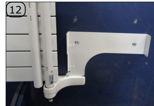
Trennen Sie das Stromkabel von der Heizpatrone, um dieses aus der Wandbefestigung lösen zu können. Der Heizlüfter ist nun vollständig ausgebaut.
