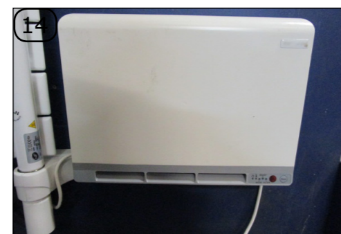
Befestigen Sie den Heizlüfter mit den vier Schrauben des alten Heizlüfters an der Halterung.
