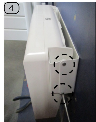
Désolidariser le soufflant de sa platine en dévissant les deux oreilles en métal avec le tournevis cruciforme.
