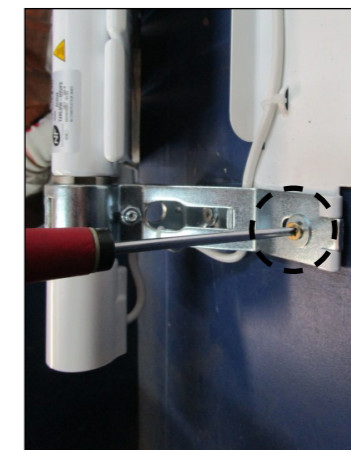
Dévisser complètement les 4 vis « apparentes » (deux vis du haut sur la platine et vis la plus à l'intérieur de l'appareil pour les consoles rotatives haut et bas).
